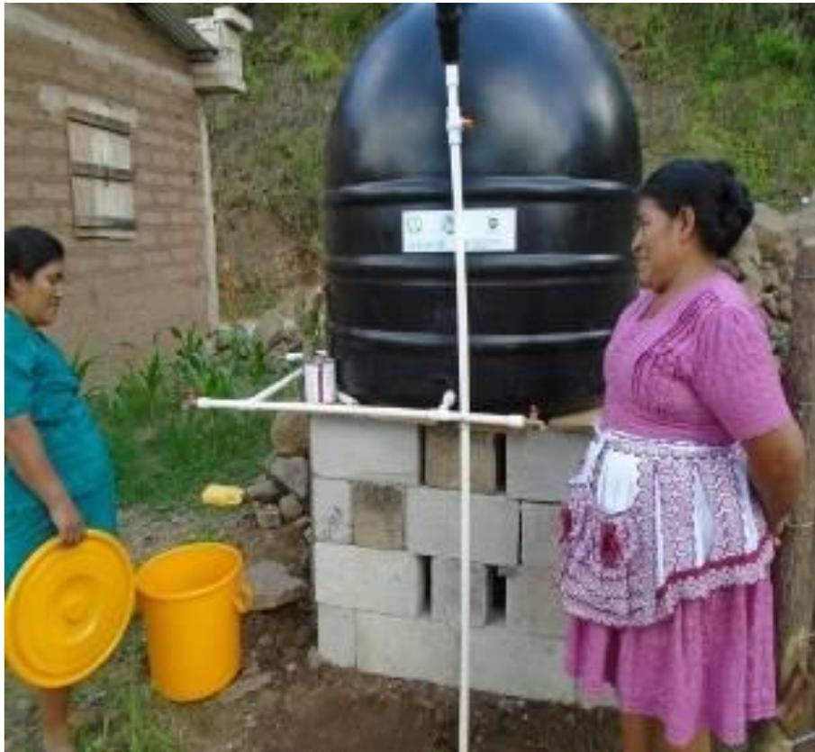
Figura de elementos técnicos prácticos de un Llenacantaro con depósito de agua con capacidad de 1,100 litros.
