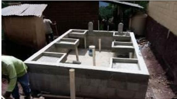
Fotografía del proceso de construcción de pila comunitaria en Plan del Mango Suchiquer, Jocotán Chiquimula.
