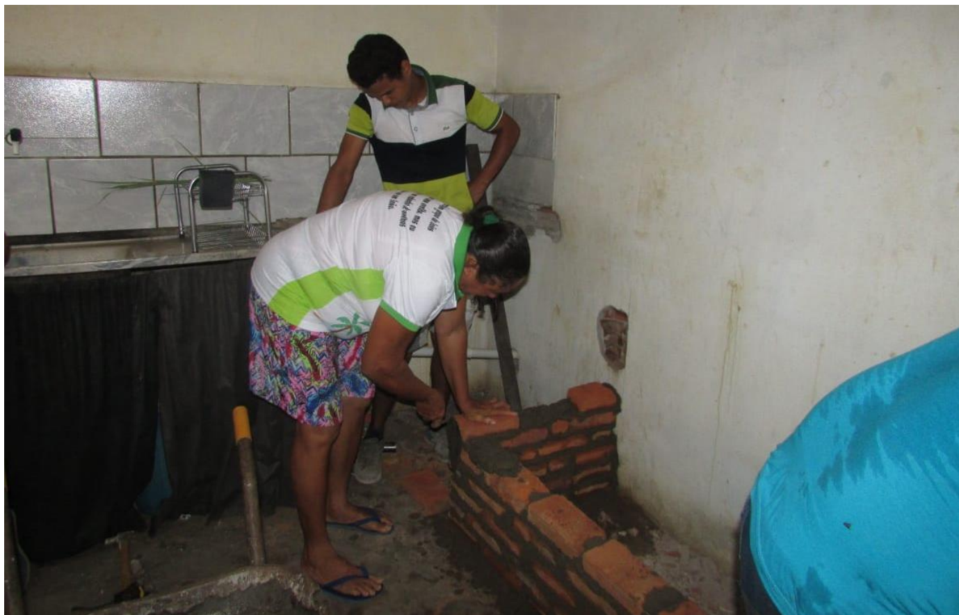
Figura 3 – Processo de construção do Fogão Agroecológico na formação em José Sotero. Fonte: Acervo CPT.
